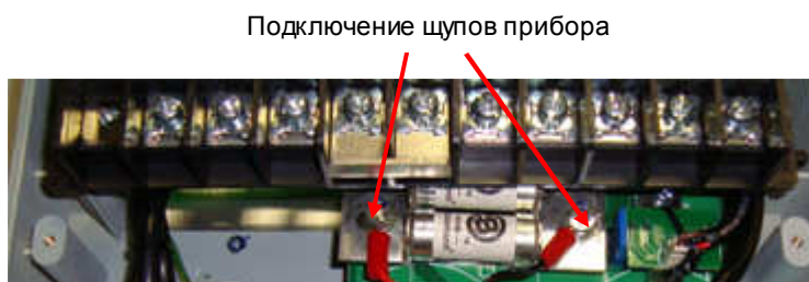
Рис. 4.15. Диагностика предохранителя
